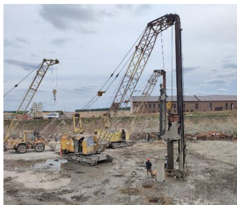
Рис. 3. Выполнение работ по устройству и испытанию опытных СПСу на площадке строительства цементного завода (респ. Мордовия)
